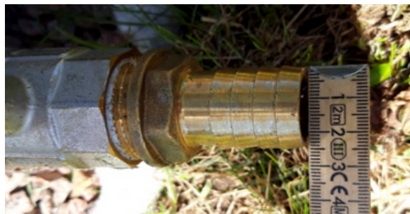
Die Abmessung des Ablasshahns beträgt 25 mm
