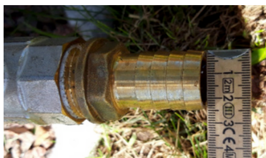
La dimension du robinet de vidange est de 25 mm.
