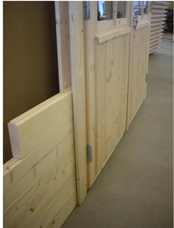
STAP 16. Plaats de wanddelen en schroef die vanaf de binnenzijde vast STEP 16. Connect with wall and connect the boards on the other side SCHRITT 16. Verbinden Sie diese mit der Wand und verbinden Sie die Bretter auf der anderen Seite
