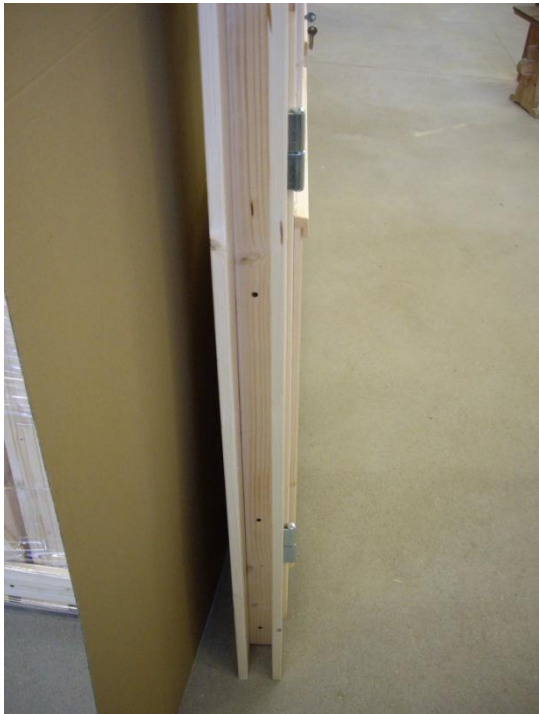
STAP 13. Zijaanzicht. Zet eerst de planken aan een kant van het kozijn vast STEP 13. Side view. Firstly assemble boards on one side SCHRITT 13. Seitenansicht. Zuerst bringen Sie die Bretter auf einer Seite an
