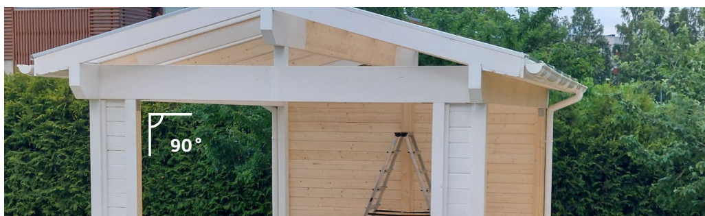
Bild 2. Kontrollera att dörröppningarna är vinkelräta
